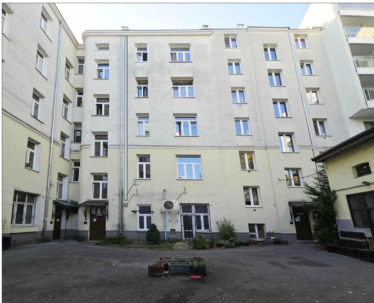
Fot. 6. Lokalizacja czerpni (1), wyrzutni z wyprowadzeniem ponad dach budynku (2), klimatyzatora (3) na tle ściany dziedzińca wewnętrznego.
